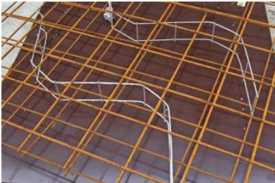
La celosía ZIG ZAG es un separador continuo que se sitúa entre las armaduras superior e inferior del hormigón para garantizar la distancia entre ellas.
